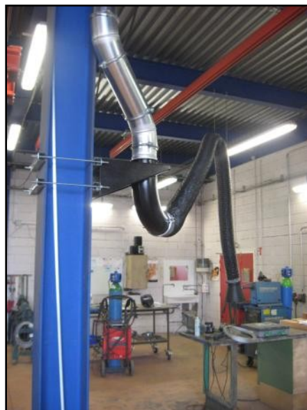
Bras autoportant de 4 m de rayon d'action
