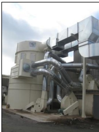
MISE EN PLACE D'UN CYCLOFILTRE
