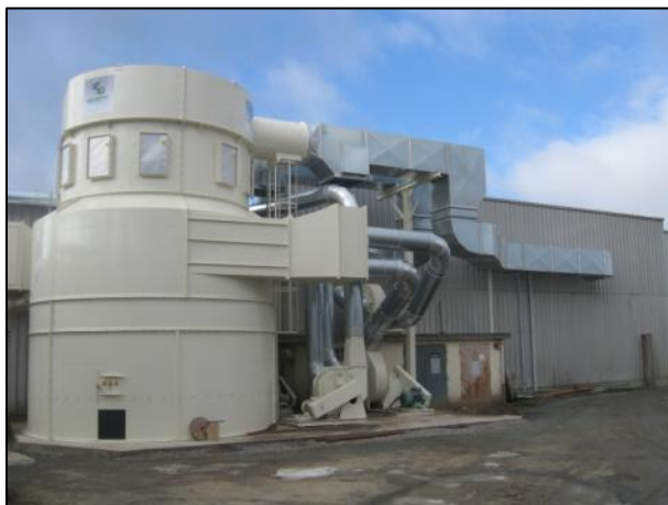
MISE EN PLACE D'UN CYCLOFILTRE
