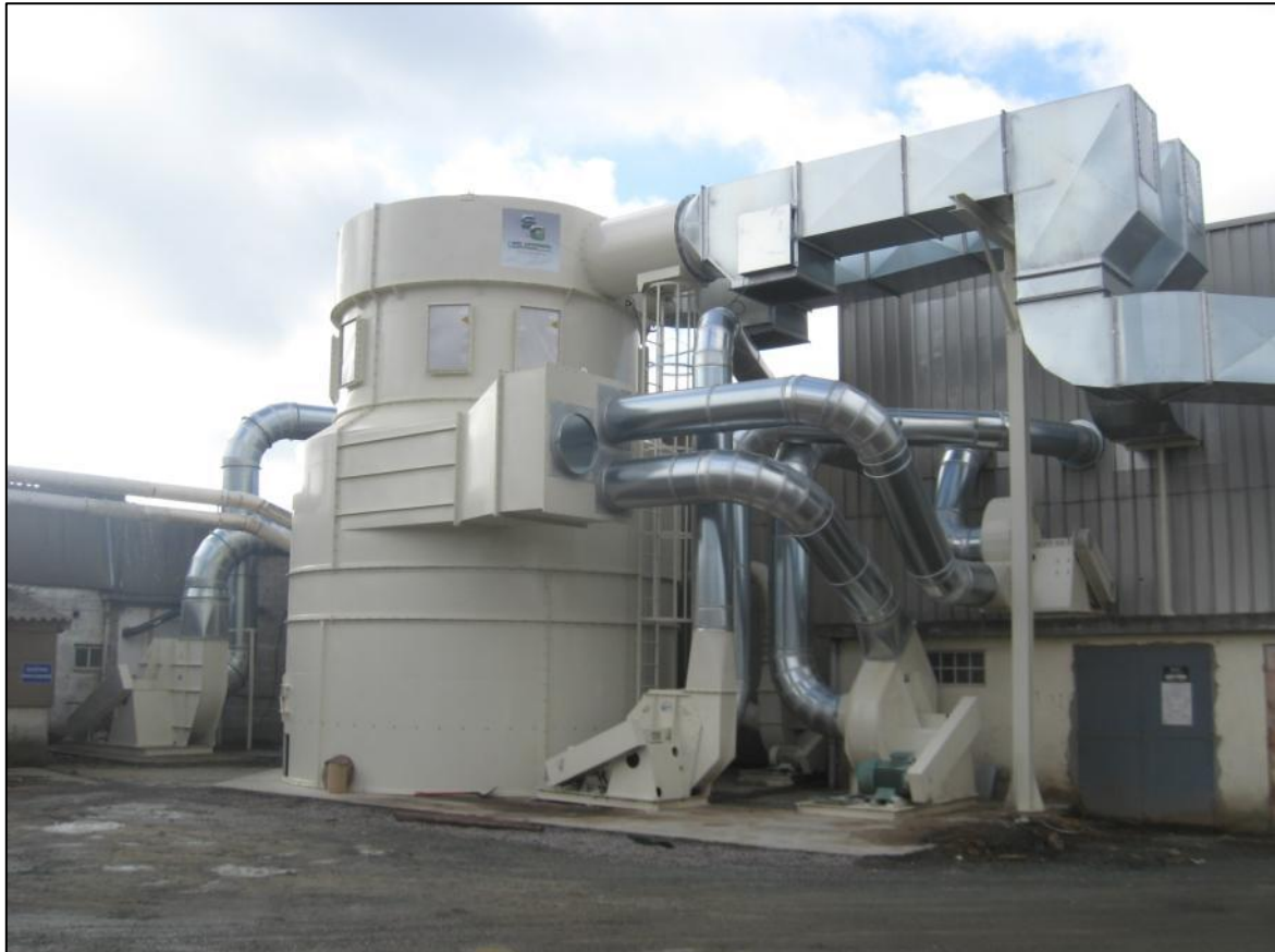
MISE EN PLACE D'UN CYCLOFILTRE
